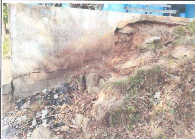
Foto 1: MEJORAMIENTO DE ÁREA DE PASILLO CON UNA CONTENCIÓN
