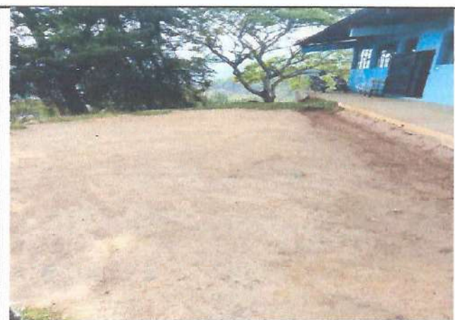
Foto 4: MEJORAMIENTO DE LOSA DE PATIO E INTALACION DE PORTICO CON LAMINA TROQUELADA CALIBRE VEINTISÉIS.
